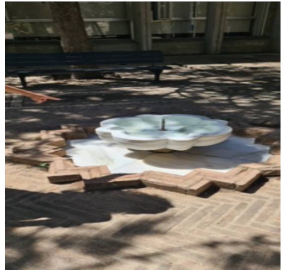
Fuentes reparadas en patio de la entrada principal
